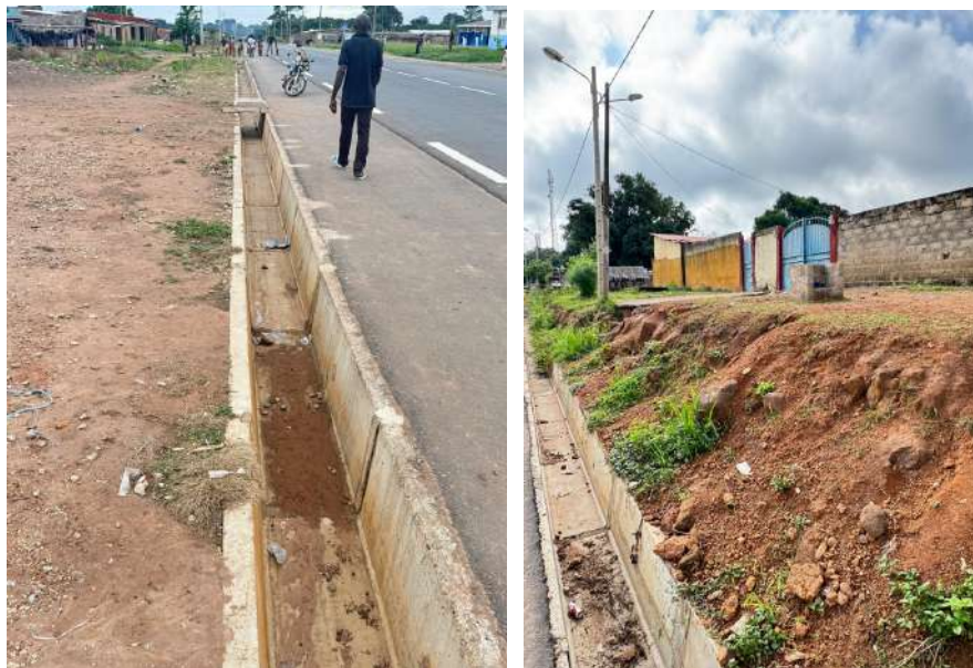
Planche 5 : Réseau de drainage partiel à Flaya et Gohitafla – Ouvrages en terre et caniveaux discontinus
